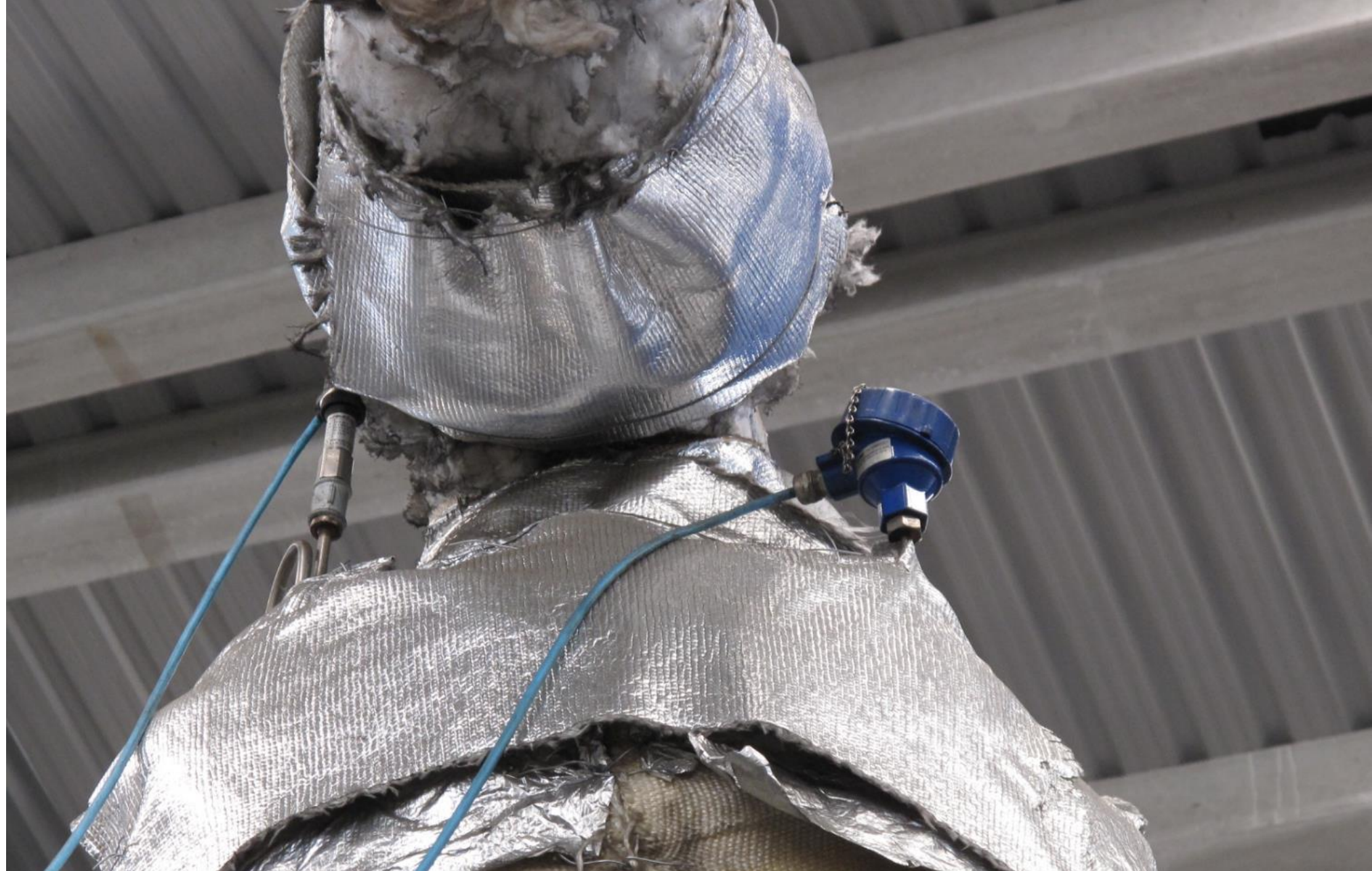
ДАТЧИК СИСТЕМЫ КОНТРОЛЯ ДАВЛЕНИЯ В РЕАКТОРЕ
